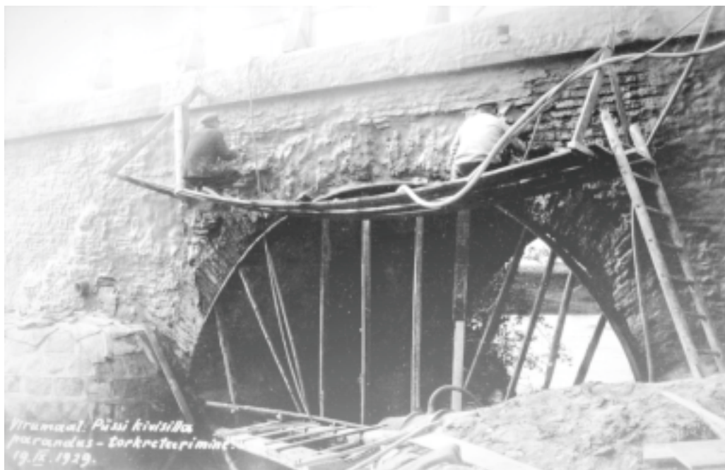
Püssi kivisilla parandamine – torkreeterimine 1929. aastal.
